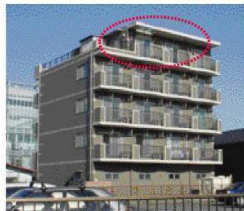
アサヒ ヒーローマンション施工例
