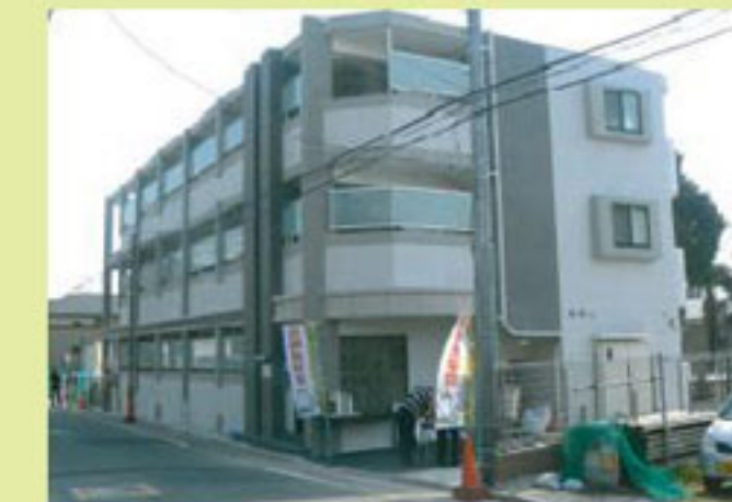
Aglaia Hakuraku 1LDK 12戸(2008.2 竣工)
