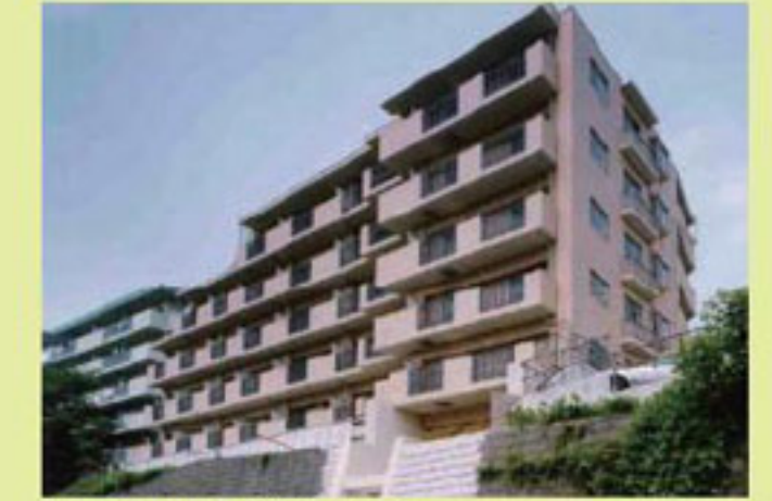
テラスハウス西大口 複合 31戸(2003.4 竣工)
