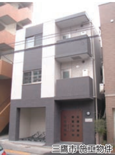
三鷹市 施工物件
