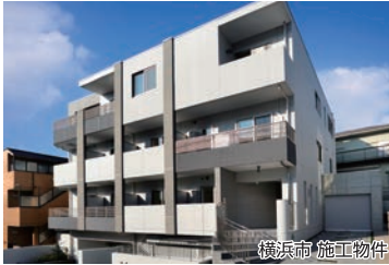
横浜市 施工物件
