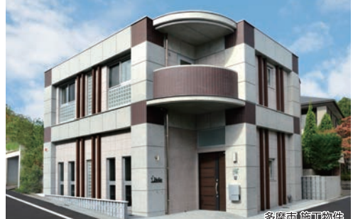
多摩市 施工物件
