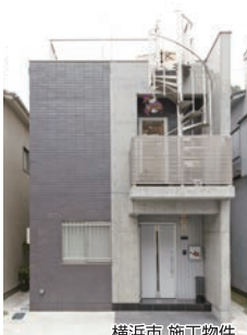
横浜市 施工物件
