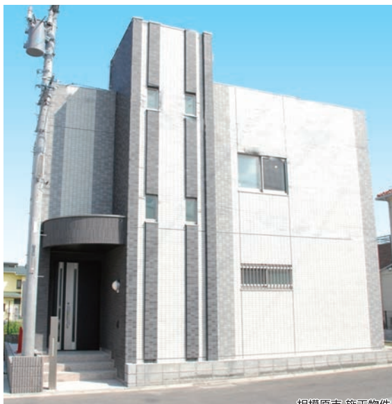
相模原市 施工物件
