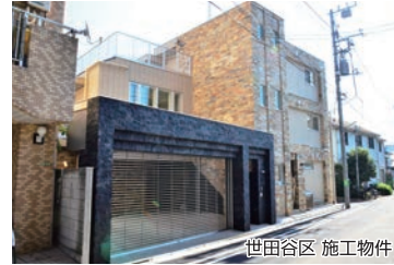
世田谷区 施工物件
