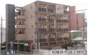
相模原市 施工物件
