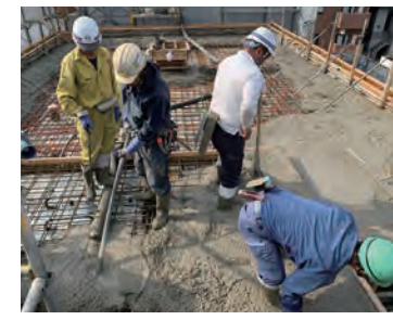
スラブ配筋後に壁とスラブへコンクリートを流し込んでいきます
