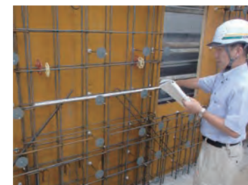
鉄筋を組んだ両サイドには型枠を設置しています
