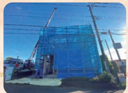
⑥ 建て方 土台の上に柱を建て、柱に梁をかけ、屋根の一番上につけられる「倒木」を取り付けると上棟です。
