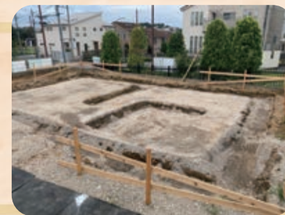
② 根伐り工事
