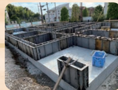
④ 基礎コンクリート打設
