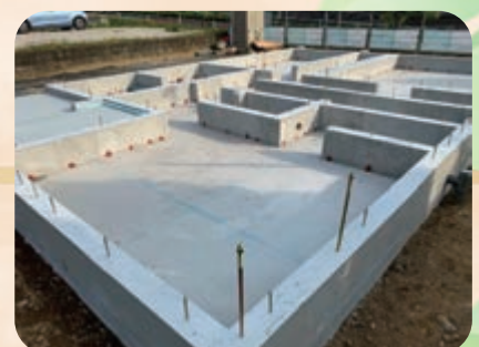
⑤ 基礎工事
