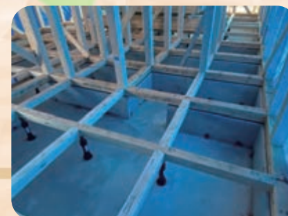
⑥ 建て方 土台の上に柱を建て、柱に梁をかけ、屋根の一番上につけられる「倒木」を取り付けると上棟です。
