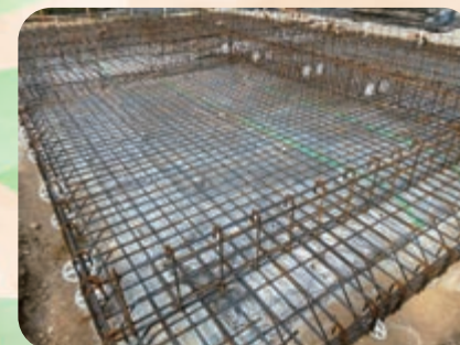
③ 基礎配筋
