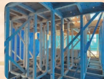
⑥ 建て方 土台の上に柱を建て、柱に梁をかけ、屋根の一番上につけられる「倒木」を取り付けると上棟です。
